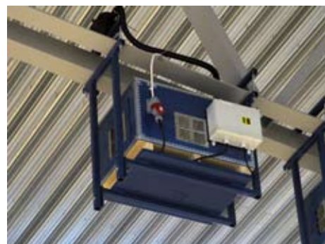
Varje station är tydligt uppmärkt på fjärrstyrningsmottagaren för att underlätta vid service.
