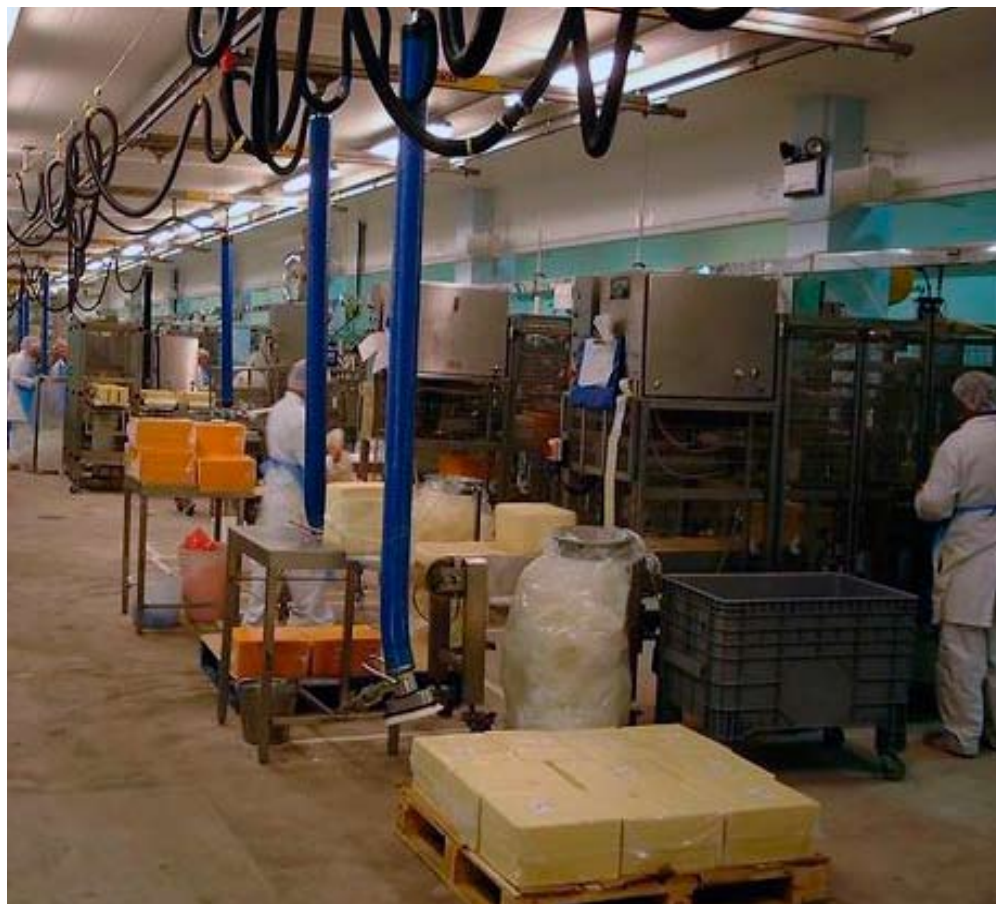
1. Rostfri modell efterfrågas ofta inom livsmedelsindustrin och läkemedelsindustrin. Bilden visar flera anläggningar i ett traversssystem monterat i en osttillverkande industri. Foto, vänster: VacuMyggan, rostfri modell, säcklyft.
